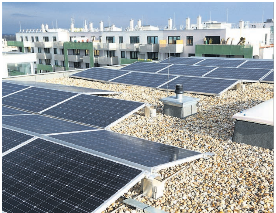
Die Photovoltaikanlage am Dach des Studentenheims „GreenHouse“ in der Seestadt Aspern deckt bei voller Sonneneinstrahlung den gesamten elektrischen Bedarf des Heimes ab.
