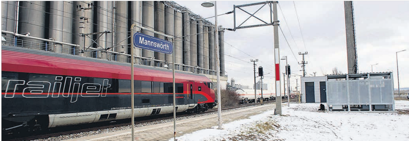
Sendestationen haben die Mobilfunkversorgung auf der Strecke Wien Mitte-Flughafen deutlich verbessert.
