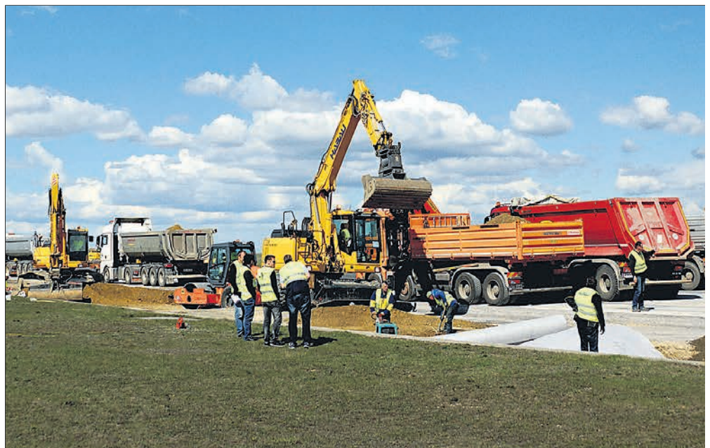
Am 6. April wird mit den Sanierungsarbeiten der Piste 11/29 gestartet.
