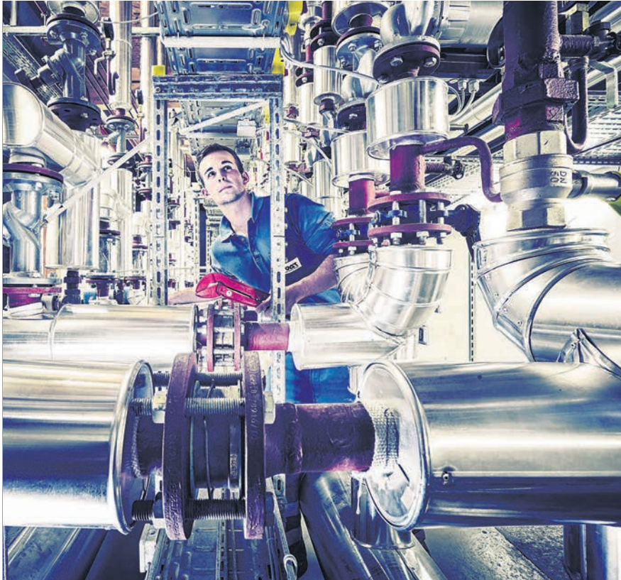
BLICK HINTER DIE KULISSEN. Der Flughafen Wien ist ein spannender Arbeitsplatz für Alexander Leicht. Dem Argusauge des Klimatechnikers entgeht nichts bei seinen Kontrolltätigkeiten im Heizverteiler.
